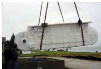
1ピースのプールをクレーンで設置場所に移動
