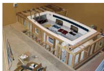
水漏れテスト後にデッキのフレーミングを作る
