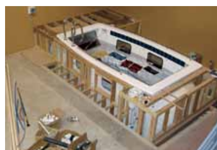
水漏れテスト後にデッキのフレーミングを作る
